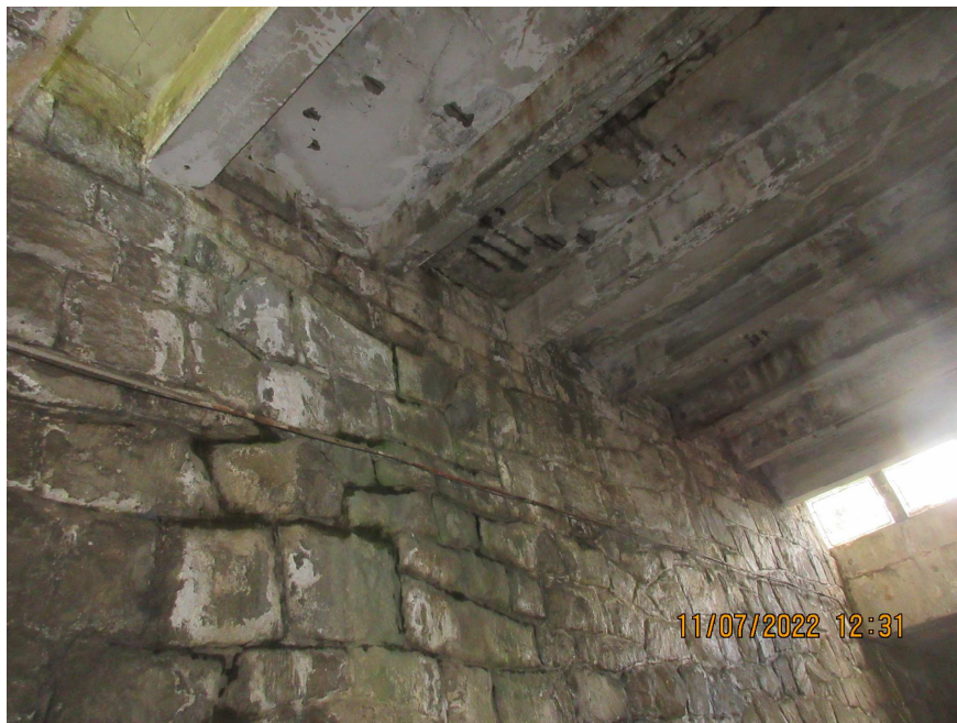
kabel VO vedený v mostním otvoru po líci opěry směr Chrást
